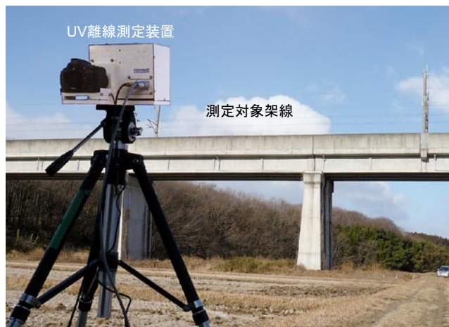
図11 地上用UV離線測定装置の測定状況
