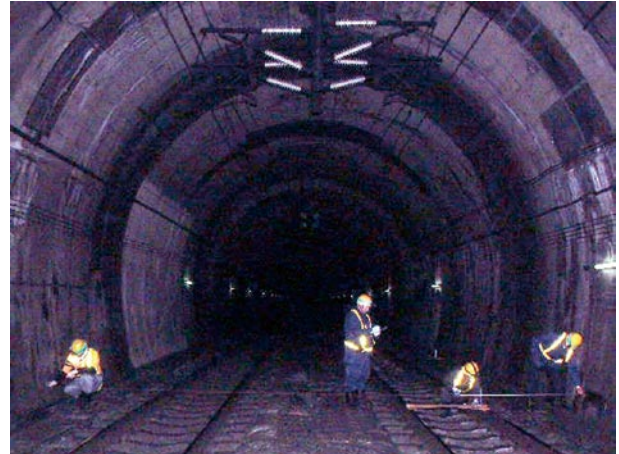
図2 手動による内空変位の計測状況
