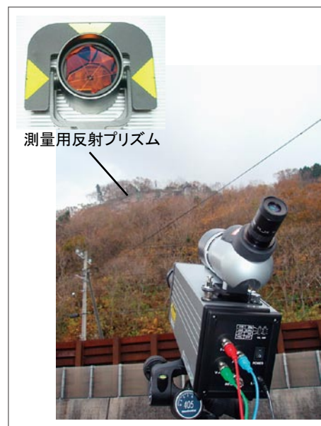
図6 測量用反射プリズムを用いた岩盤計測状況
