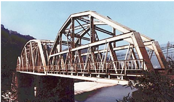
1896年製造 関西本線 大河原・笠置間 木津川橋りょう
