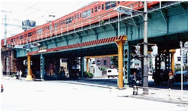
1904年製造 中央本線 神田・お茶の水間 昌平橋架道橋
