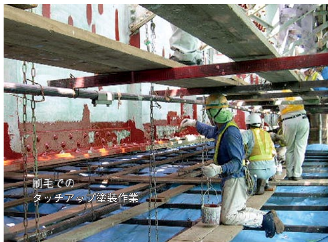
図7 塗替え塗装作業風景
