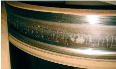
図8 車輪踏面熱き裂の例
