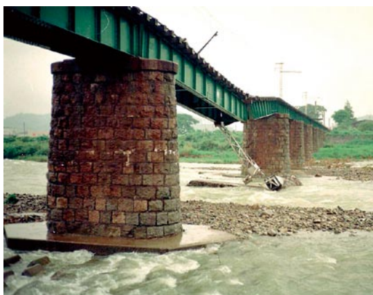
図1 橋脚が倒壊した河川災害の例
