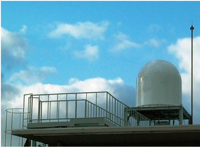
図4 余目駅に設置されているJR東日本のドップラー気象レーダー
