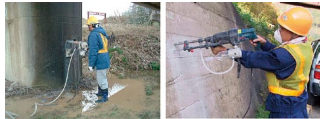
(a)コア法 (b)ドリル法 図8 塩化物イオン濃度測定のための試料採取の例
