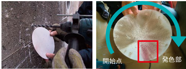
(b) 中性化深さ測定 (ドリル法)
