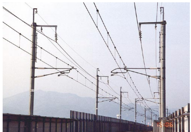
図12 新幹線用高速シンプル架線
