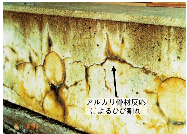
図10 軌道スラブのアルカリ骨材反応
