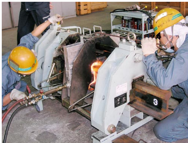
図 水素ガスを用いたレールのガス圧接作業状況
