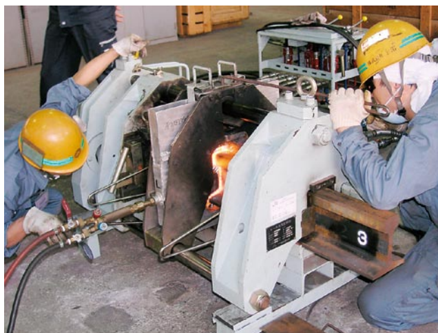
図 水素ガスを適用したレールのガス圧接作業状況
