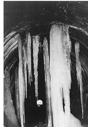
図2 鍾乳石のようにトンネルアーチ部から成長したつらら
