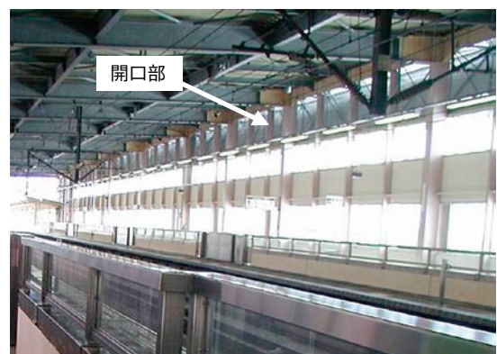
図10 開口部の増設例
