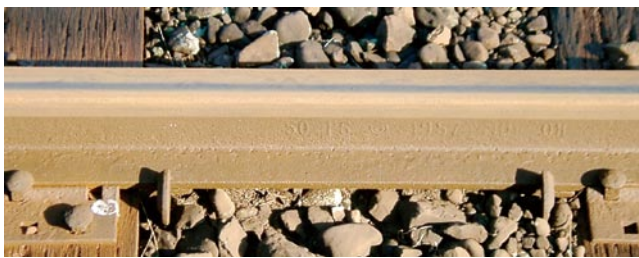
図3 一般的なレール面の赤さび
