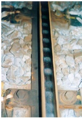
図9 急曲線内軌波状摩耗の例
