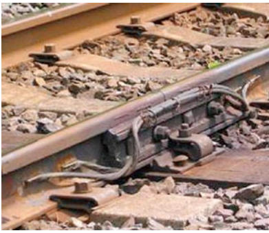
図14 継目部のレールボンド
