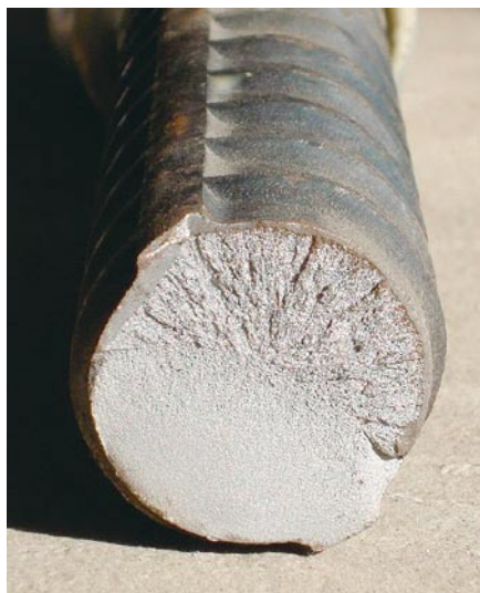
図9 疲労破断した鉄筋の破断面
