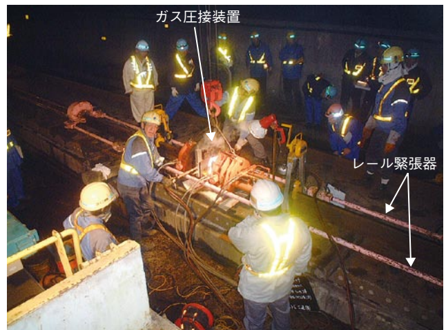
図4 緊張ガス圧接工法
