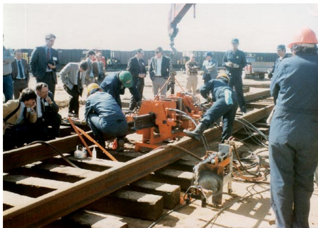
図2 米国プエブロ試験線でガス圧接
