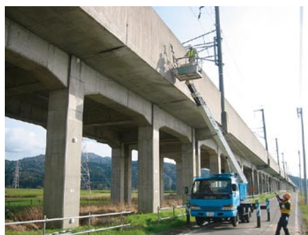
図2 ラーメン高架橋の衝撃振動試験風景
