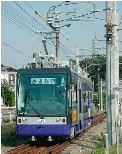
図8 剛体架線からの急速充電 (バッテリー充電電流1000A-60秒以上)
