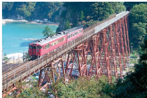
図1 保守担当者の努力により100年近く風雨に耐え続けた餘部橋梁（1912年製）
