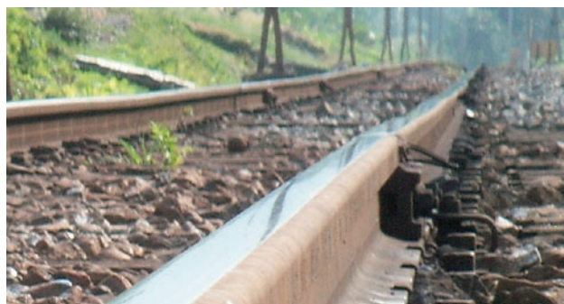
図1 レールの曲がりである軌道変位
