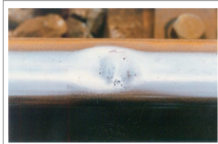
(1) レールシェリング外観
