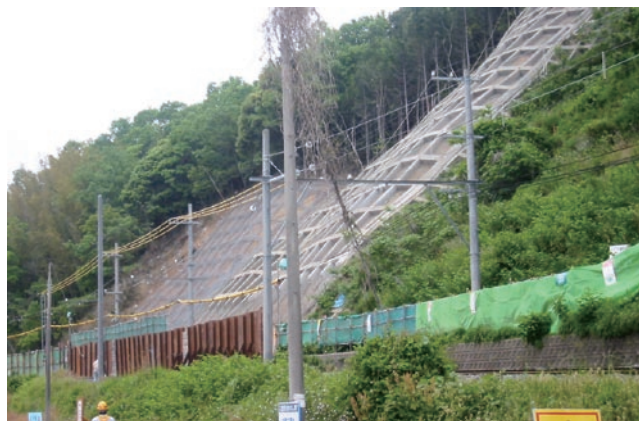
図2 大雨による土砂崩落の復旧状況(一畑電車)
