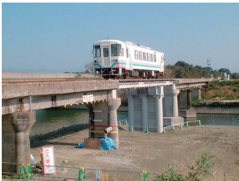
復旧後の宝満川橋梁を走るレールバス
