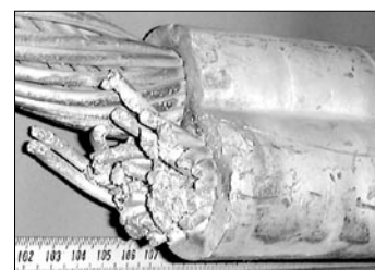
図3 圧縮管出口付近で溶断した硬アルミニウムより線
