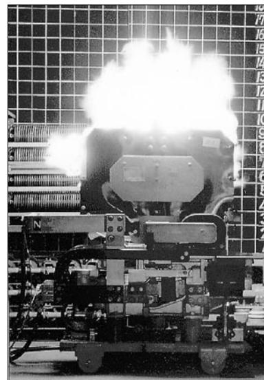
図4 気中式直流高速度遮断器 (電流遮断中)
