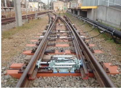
図 18 所内試験線の 8 番分岐器への敷設状況
