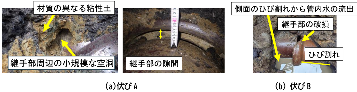
図4 伏びの掘削状況
