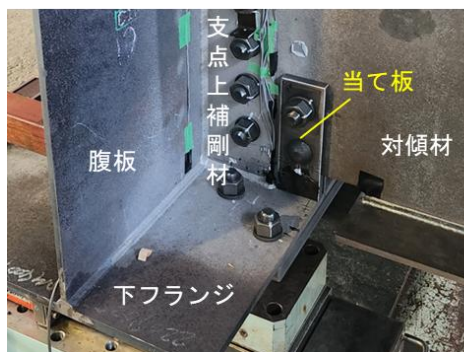
図 5 当て板の設置状況
