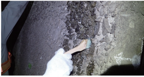
図 23 プライマー塗布状況
