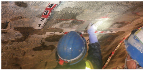
図6 止水モルタルによる仮止水の施工状況
