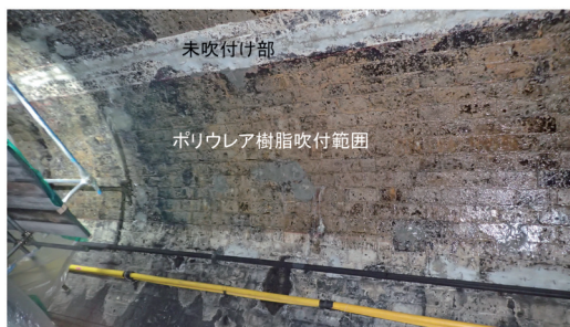
図16 施工後の覆工表面の状況
