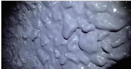
図 24 ポリウレア樹脂吹付け後の覆工状況
