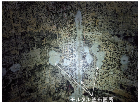
図15 導水の例(クラウン部)
