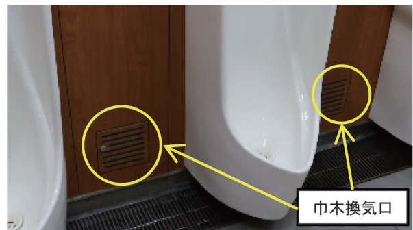
図6 巾木換気口の例（図11と同じトイレ）
