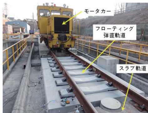
図9 モータカー走行試験の様子
