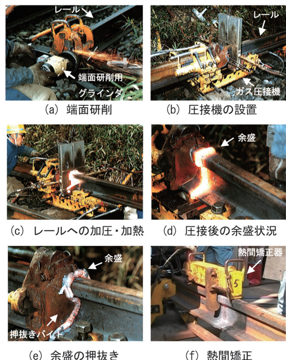
図1 レールガス圧接施工手順
