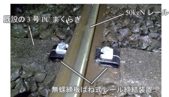
図 17 敷設後の状況
