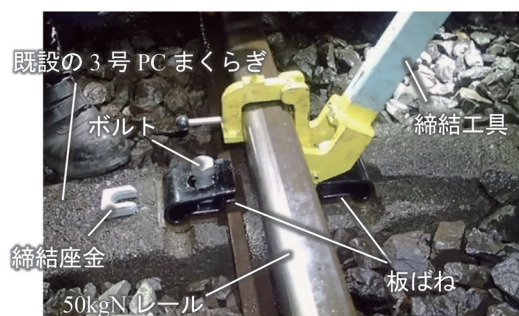
図 16 締結工具を用いた施工の状況
