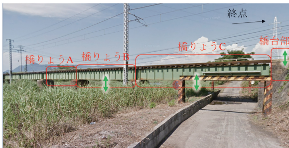
図2 対象橋りょうの写真
