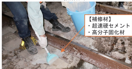
(b) 補修材投入
