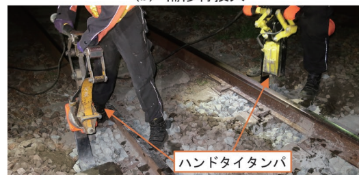
(c) つき固め作業
