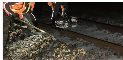
(a) 掘削作業
