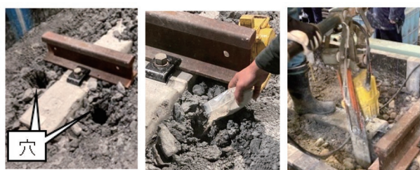
(a) 掘削作業 (b) 補修材投入 (c) つき固め作業
