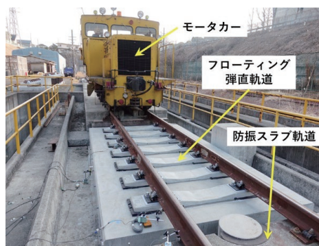
図12 施工後の状況
