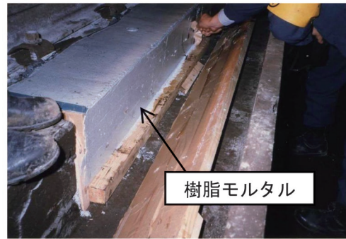
図4 軌道スラブ肩部に対する断面修復の状況
