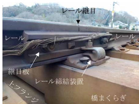
図1 レール継目の構造(支え継ぎ)
