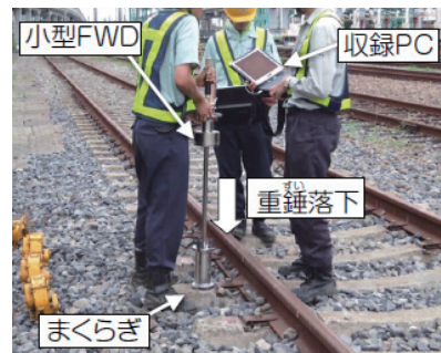
図10 小型 FWD を用いた軌道支持剛性測定 23)
