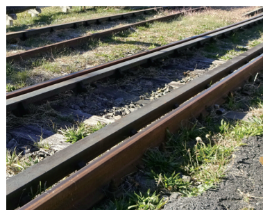
図 12 在来線用脱線防止ガード
