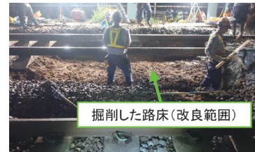
(a) 路床土の掘削
