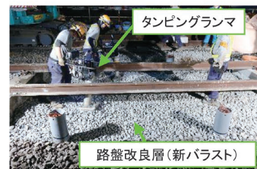
(b) 路盤改良層の締め固め
