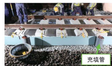
(c) 省力化軌道に用いる型枠の設置
