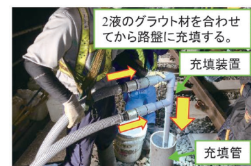
(d) グラウト材の充填作業
