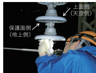
図3 実設備における筆洗い法によるがいし汚損度測定の様子
