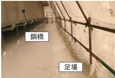
図9 熱収縮シートを用いた鋼橋の養生例
