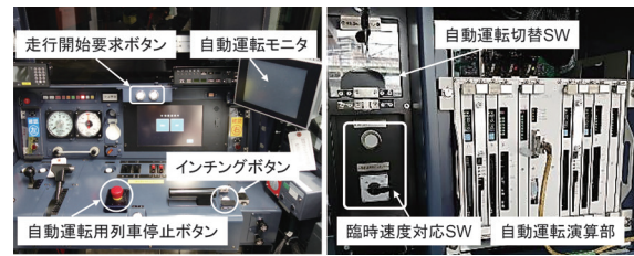
図5 供試車両への量産版試作装置の仮設状況
