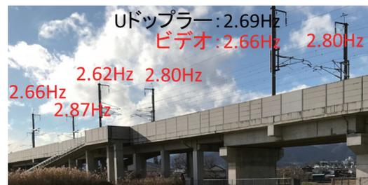
図7 架線柱の固有振動数の一括測定結果例
