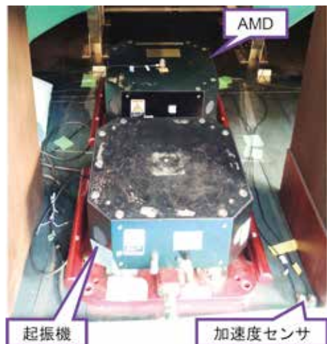
図10 営業車両への起振機およびAMDの設置状況
