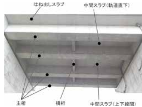
図1 対象構造物の外観
